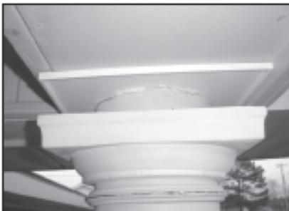
4. Continúe con el Paso 5 de las “Instrucciones de instalación de fibra de vidrio redonda o cuadrada (FRP)” que se incluyen con la columna
